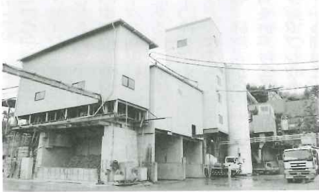
併設したリサイクルプラント(手前)と バッチャープラント
