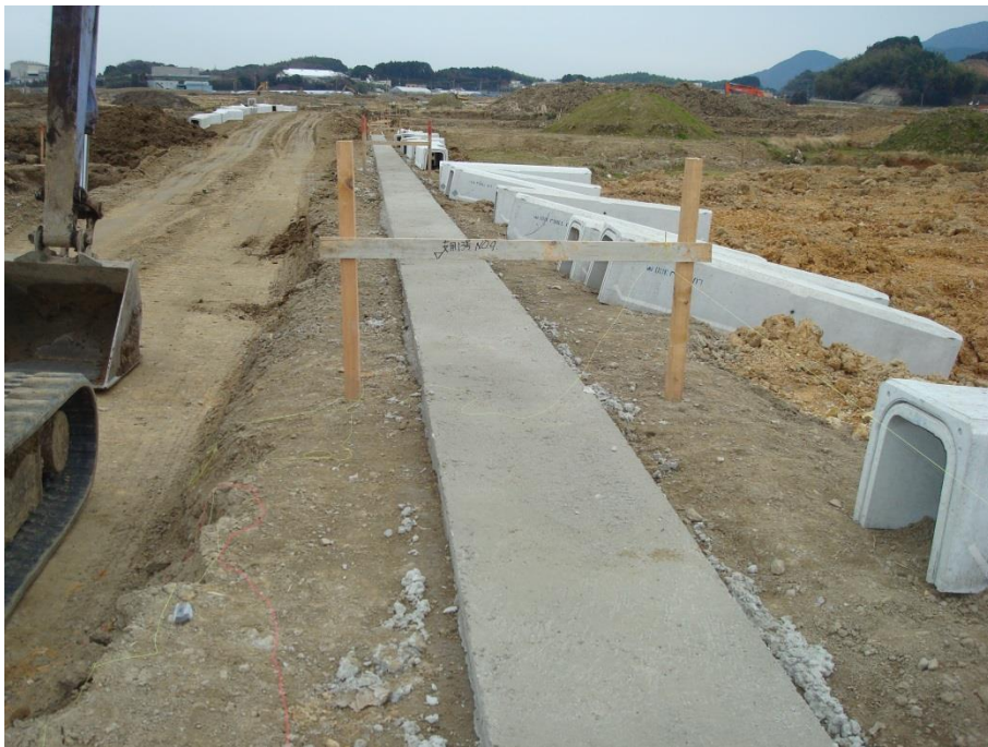
* 側溝基礎コンクリート
