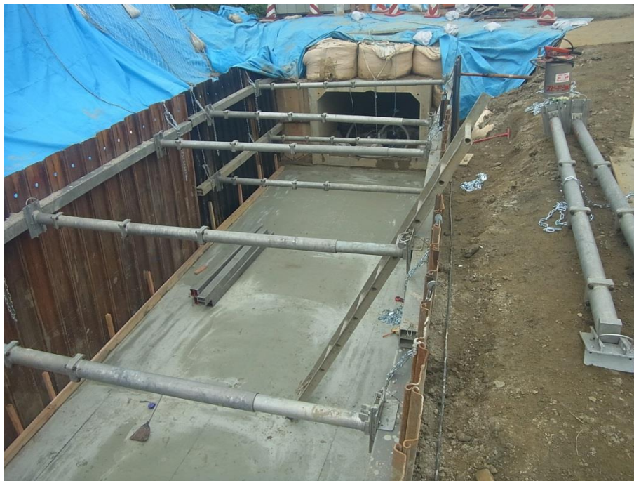
* BOXカルバート基礎コンクリート
