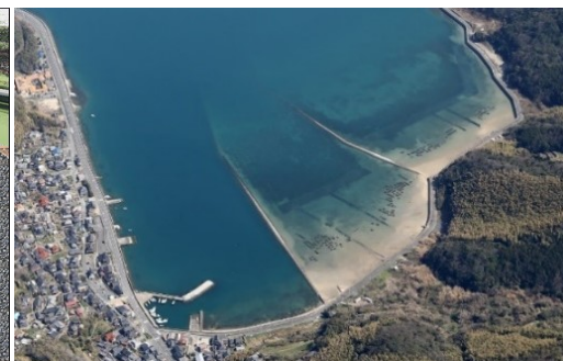
【浚渫土砂を活用した干潟の整備】
