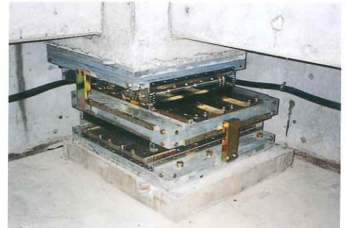
この建築物は、世界初の「偏心ローラー支承」方式による免震構造になっています。
