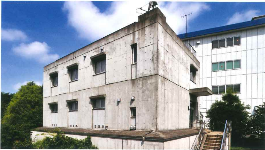
この建築物は、世界初の「偏心ローラー支承」方式による免震構造になっています。
