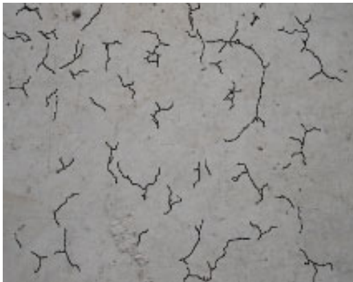
図-4.1 微細クラック発生状況
